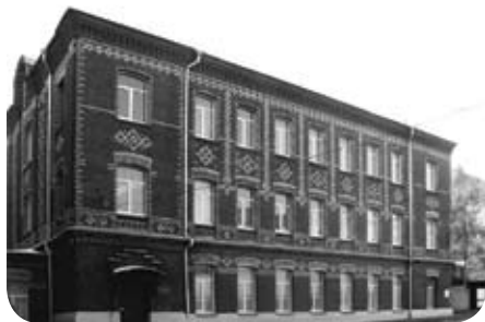
Одно из зданий КТУ, построенных в начале XX века
